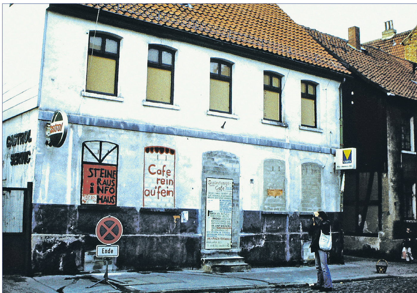
Die Viktoriastraße im Jahr 1979: Schriftzüge am zugemauerten Haus Nr. 30.
