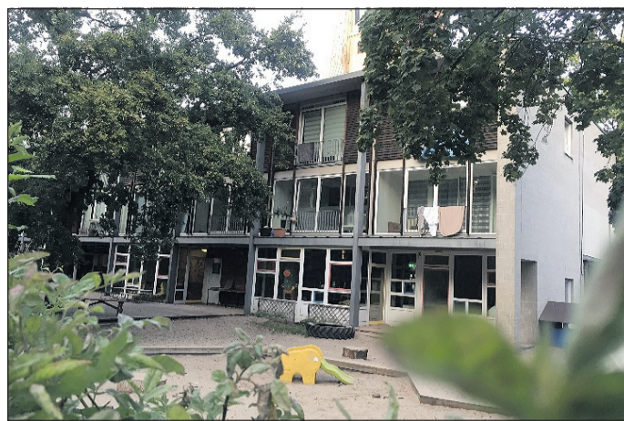
Neubauwohnungen mit Kita im Erdgeschoss Nollestraße 28.
