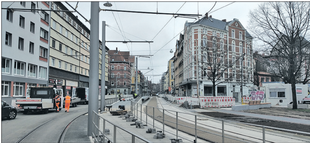
Wird vermutlich deutlich teurer: der seit zwei Jahren im Bau befindliche Hochbahnsteig am FZH Linden.
