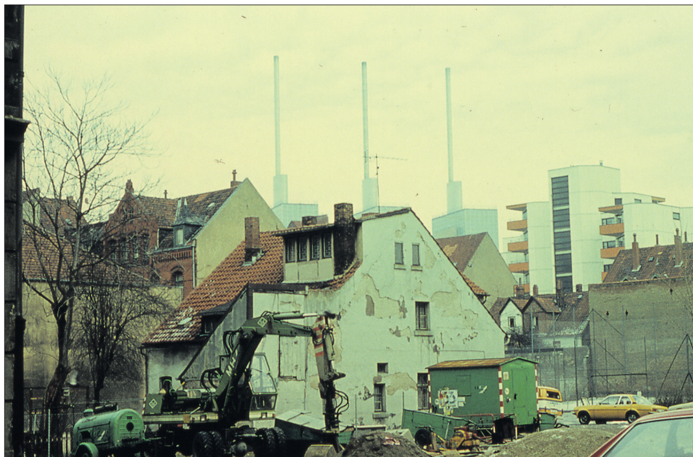
Viktoriastraße 3 und die hier schon abgerissene Nr.4 Ende der 1970er Jahre
