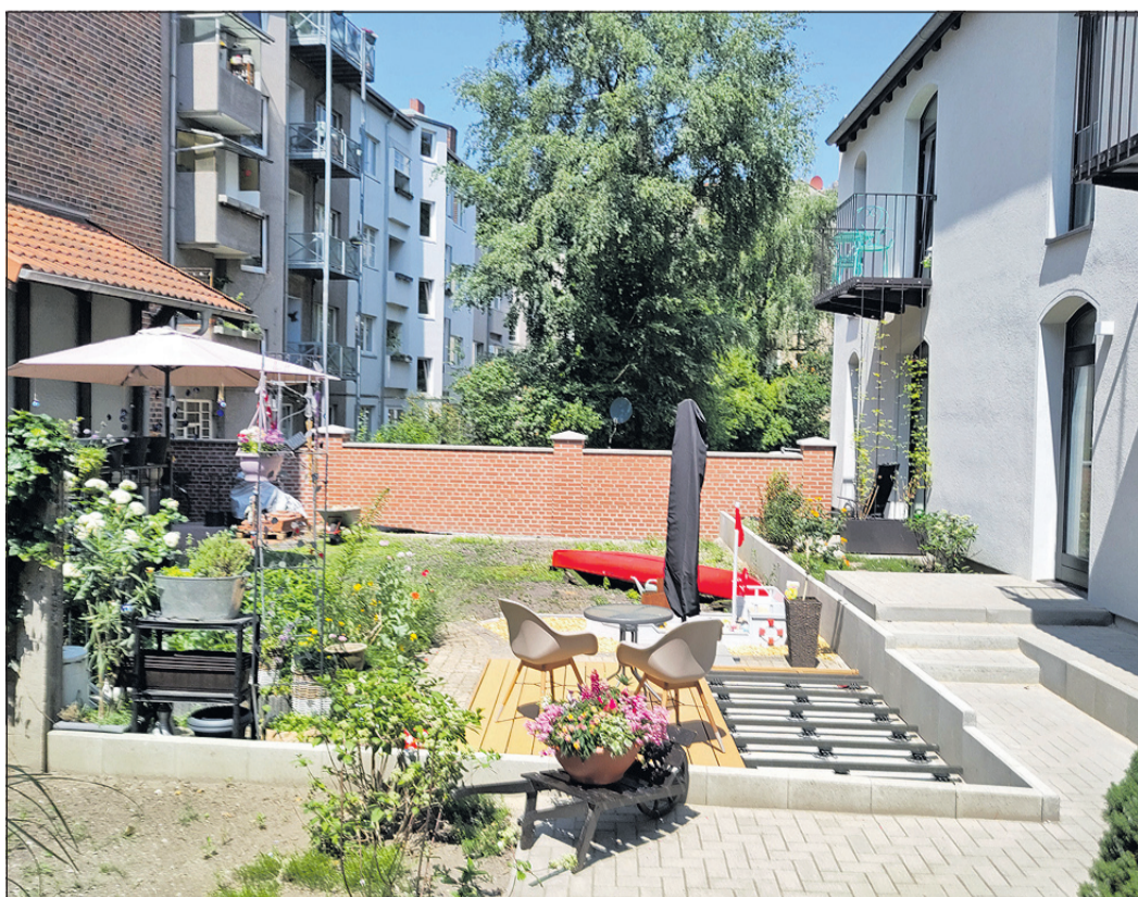
Der Innenhof (noch im Umbau) und die neuen Wohnungen in der ehemaligen Kegelbahn heute.
